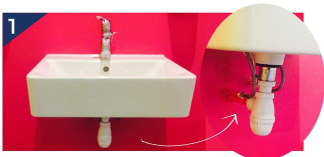
La plupart du temps, les siphons sont dissimulés, derrière un meuble ou par une colonne, retirez-les pour entamer toute manipulation du siphon.
